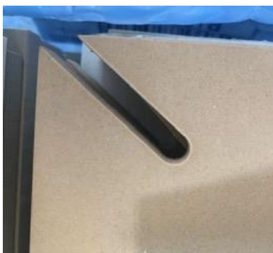
Fig 32 Esempio di apertura per cavo alimentazione nello spigolo
