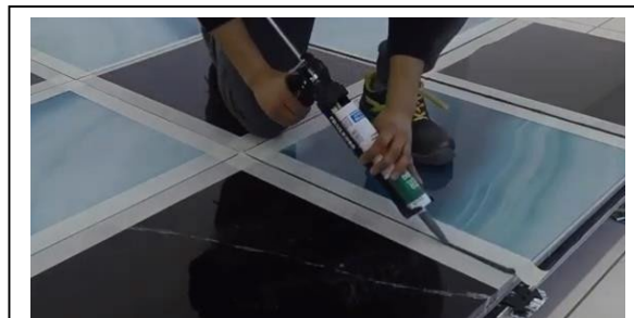
Fig 35 Esempio di sigillatura con silicone.
